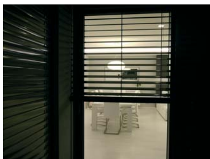
Vonkajšie žalúzie sú tiež centrálné riadené Foxtrotom. Mimo komfortného ovládania plní Foxtrot aj funkcie bezpečnostné: v prípade silného vetra sa zatiahnu. Púšťanie svetla dovnútra či zatiahnutie zase naopak šetrí energie za vykurovanie či chladenie. Každá automatická akcia žalúzií sa dá nastavovať pre každé okno kedykoľvek samostatne priamo užívateľom.
