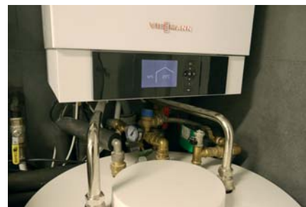
Displej kotla zobrazuje vonkajšiu teplotu, teplotu vykurovacej vody na výstupe z kotla a referenčnú teplotu v obytnom priestore. „Externé zapojenie“ indikuje, že kotel dostáva riadiace inštrukcie zo systému Foxtrot podľa aktuálnej potreby domu.
